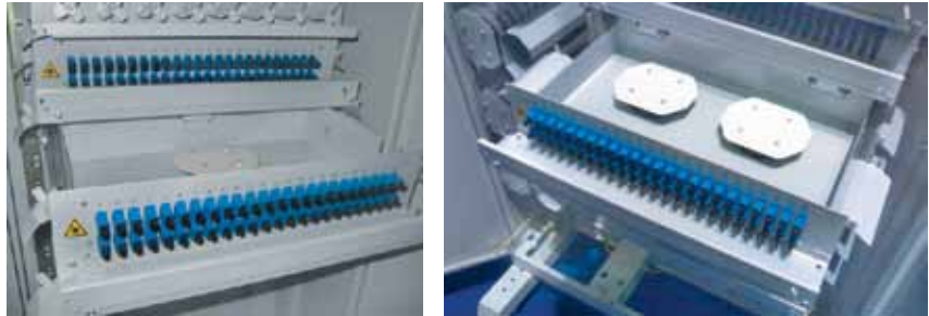
Коробка R-349-10-2U для монтажа 1 модуля на 48 портов.
